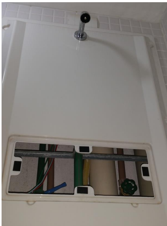
Foto 03: Vista de parede com Shaft de instalações onde internamente passam tubulações de várias instalações que interligam os andares superiores e os inferiores, sendo impraticável modifica-los ou mesmo eliminá-los.
